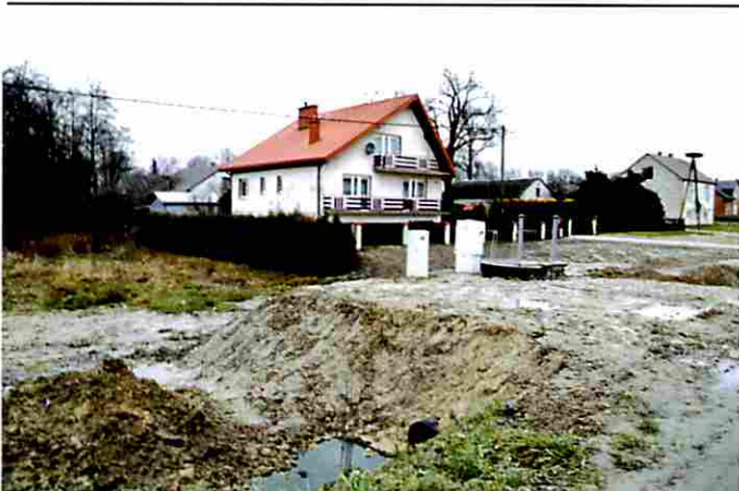
Kanalizacja w Woli Różanieckiej
