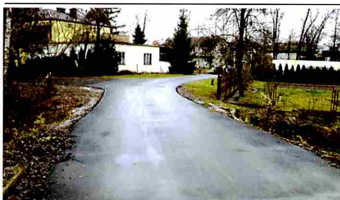
Nowa nawierzchnia na ulicy Nadrzecznej
