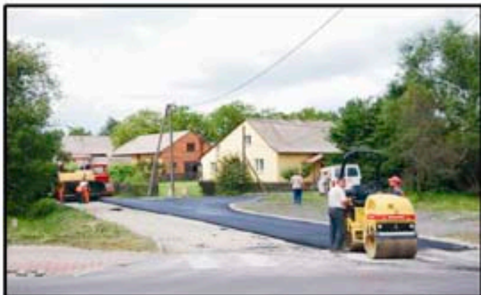
UKŁADANIE NAWIERZCHNI UL. POLNA
