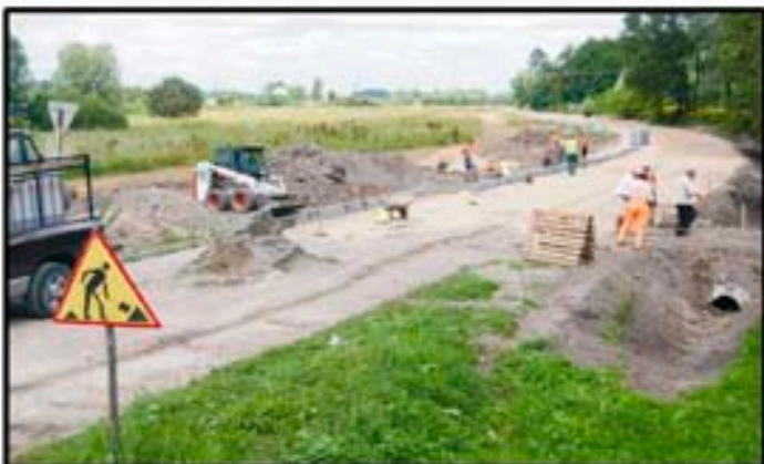
BUDOWA DROGI PRZEDM. PŁUSKIE
