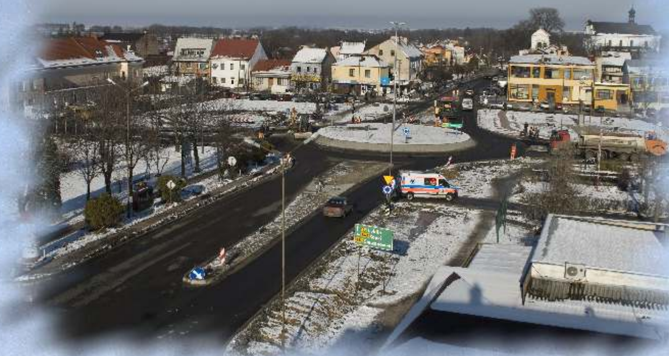
Budowa ronda w Tarnogrodzie
